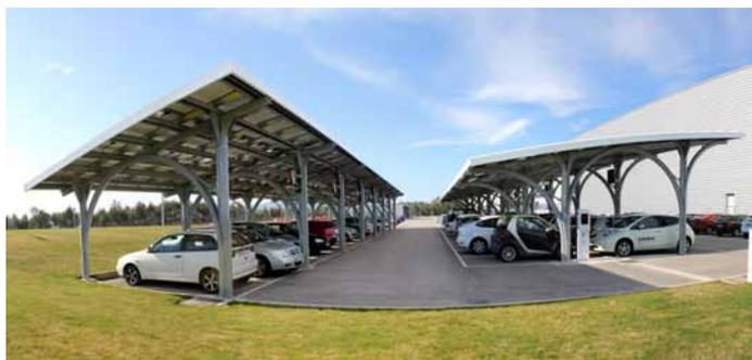
SmartPark® è una soluzione integrata per il parcheggio delle auto sviluppata per unire una struttura architettonica di copertura dei veicoli con un sistema di produzione di energia solare. Questa Soluzione di Parcheggio FV consiste in un pannello composto da diversi moduli FV con un'inclinazione di 10° montato su una struttura di acciaio zincato e collegato ad un gruppo di inverter.
